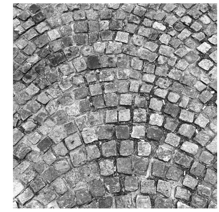
17 FISHSCALE SPALL - PATTERN SCALE: NTS
