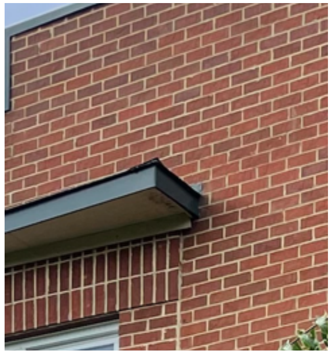
Rotten Soffit
