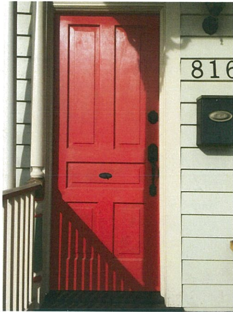
Front door close up
