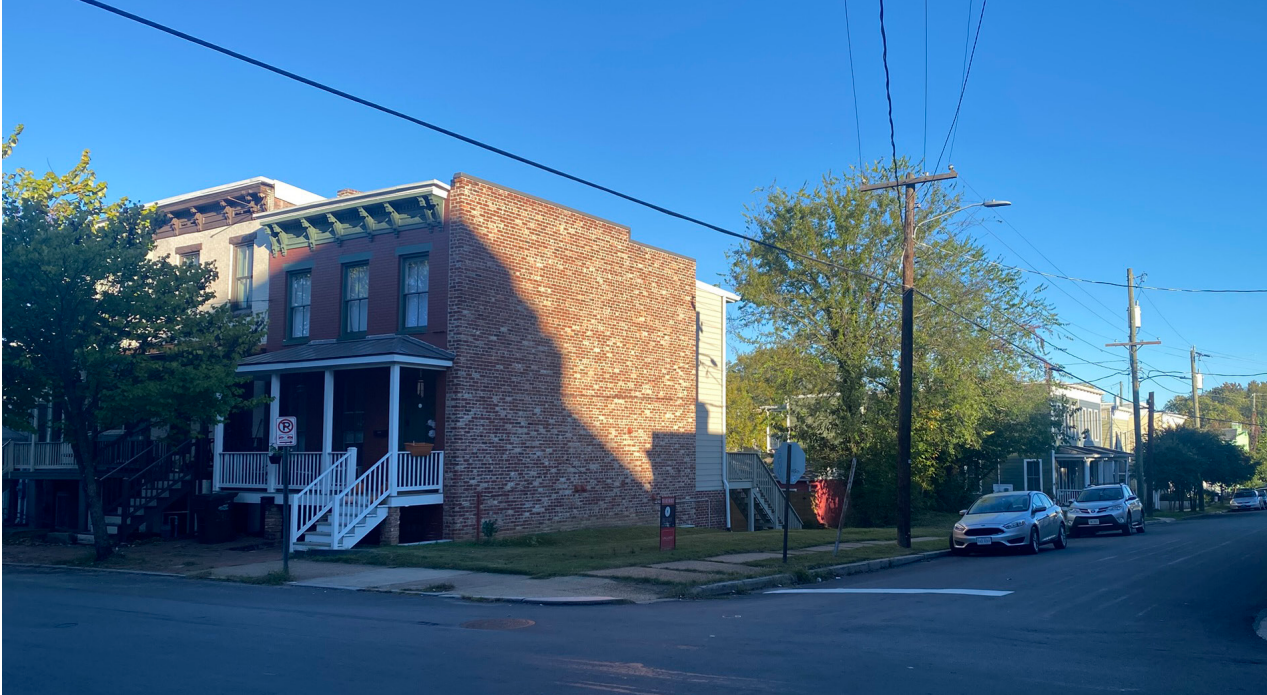
2322 VENABLE - PROJECT SITE
