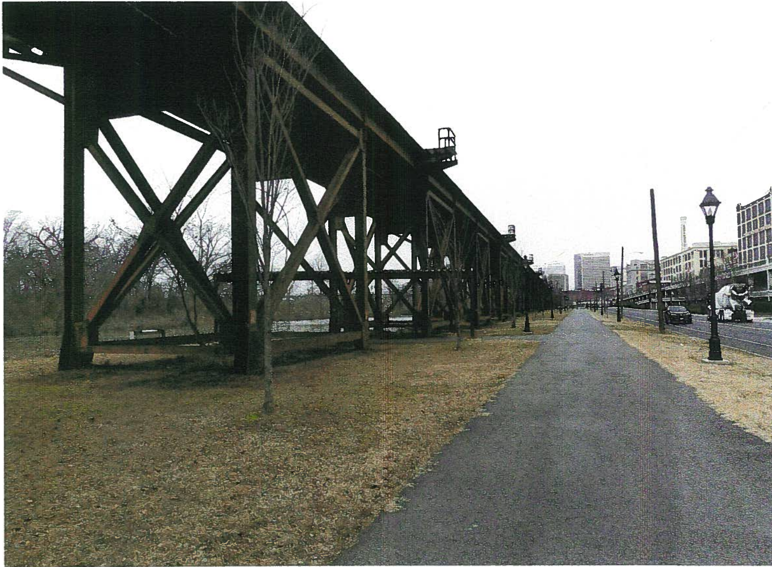
LOW LINE GARDENS (D) - EXISTING CONDITION
